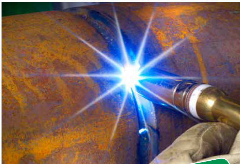
IAC™ : soudure d'amorçage verticale descendante sur une canalisation de chauffage urbain. Vitesse d'exécution nettement accrue par rapport au soudage vertical ascendant classique.
